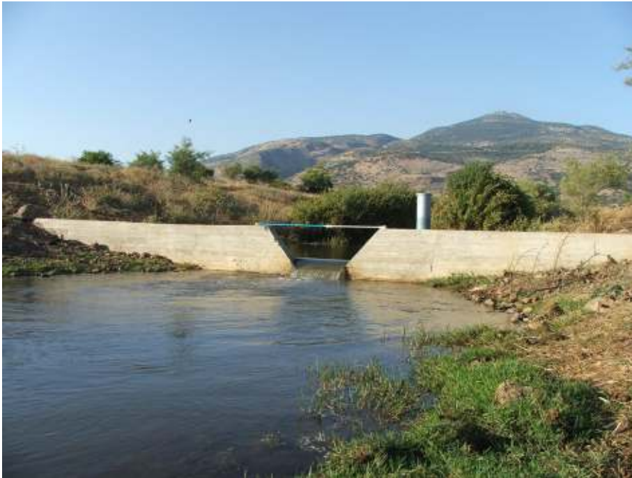
תמונה 2 : סכר ומגלש טרפזי למדידת ספיקה אשר הותקנו בתעלת הנוחיילה בשלב השני של העבודה.
